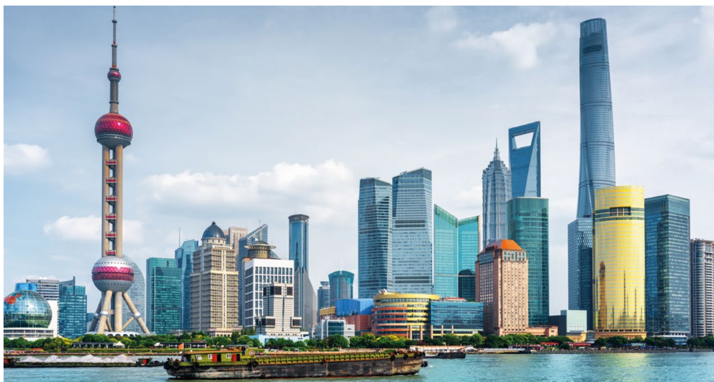
Shanghai, distretto di Pudong
