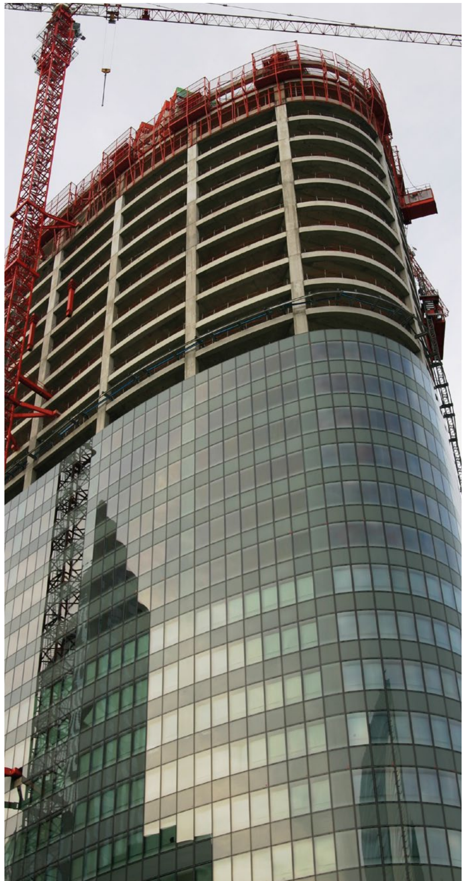
Parigi, la Défense, uffici in costruzione
