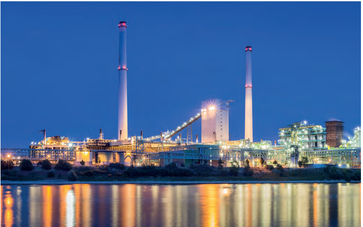
Duisburg, impianto di produzione energetica
