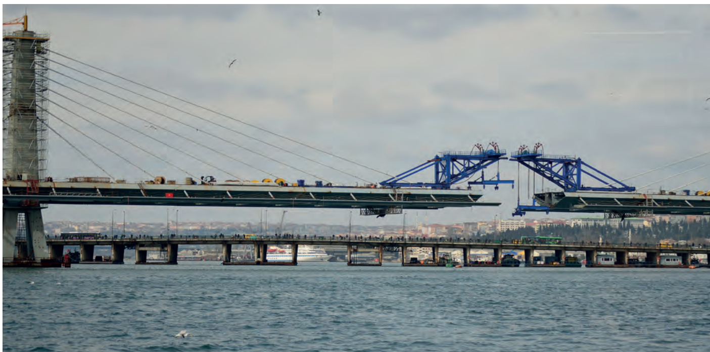
Istanbul, costruzione del ponte Golden Horn
